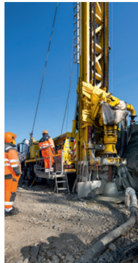
Des foreuses percent jusqu'à 800 mètres de profondeur pour installer des sondes géothermiques aux Plaines-du-Loup.
